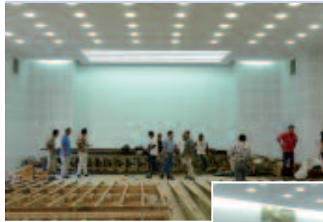
Amphithéâtre en construction
